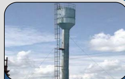
Диспетчеризация Водонапорных башен
