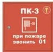
Следует установить таким образом, чтобы отвод, на котором он расположен, находился на высоте (1,35+0,15) м над полом помещения, и размещать в специальных шкафах. На каждом этаже производственного или общественного здания должно быть не менее 2 пожарных кранов.
