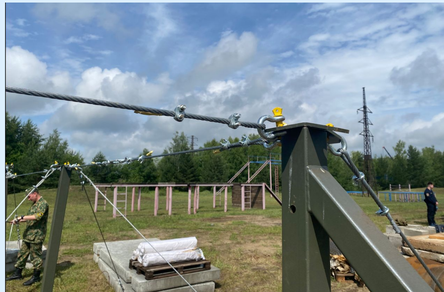
Узел крепления тросов к стойке
