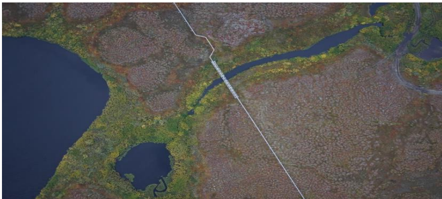
Мониторинг состояния трубопроводов
