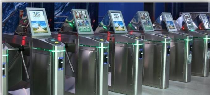
**Оснащены входные линейки турникетов аппаратурой радиационного контроля на всех станциях (83 комплекта оборудования)**
