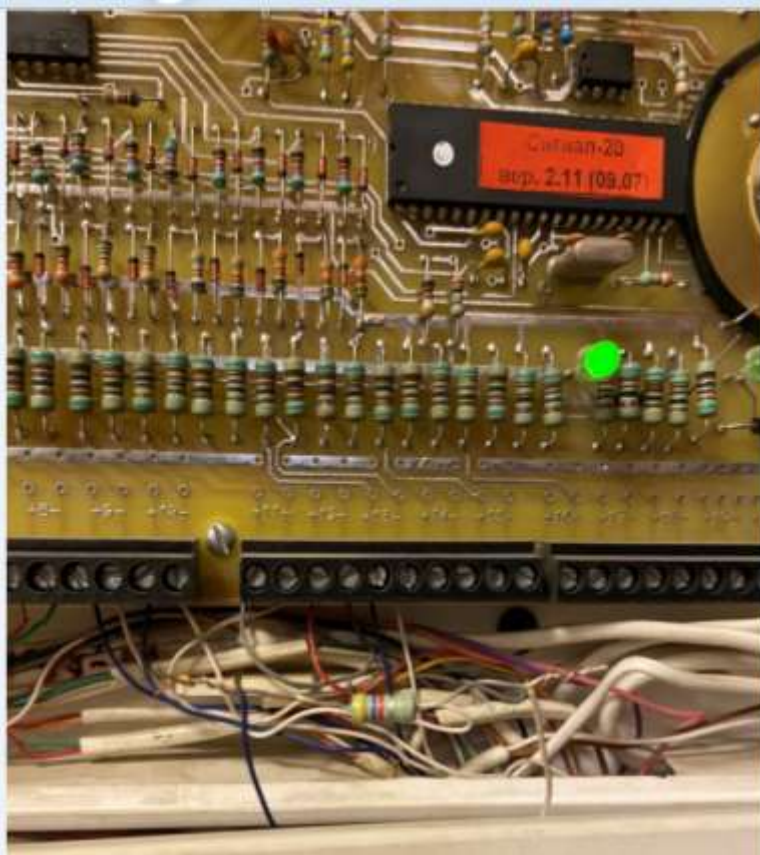
Установка шунтов в приемно-контрольных приборах
