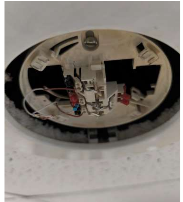
Изменение полярности при подключении ДИП
