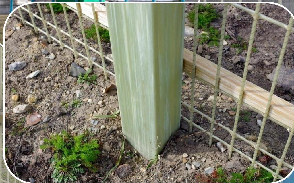
Стойка опорная. Установка стойки в грунт бетонированием
