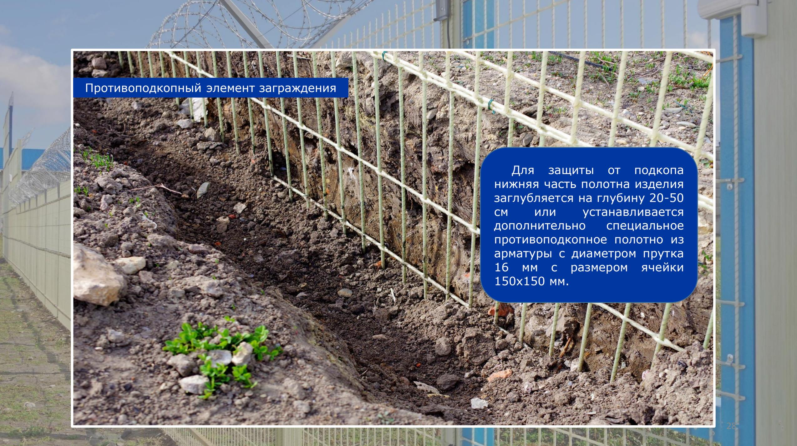
Противоподкопный элемент ограждения
