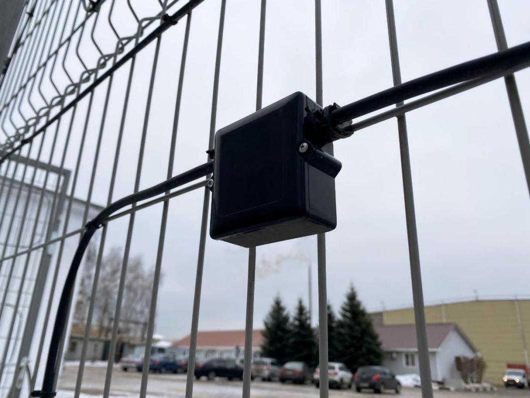
**Датчики устанавливаются в линии КСОД через каждые 3–9 метров на ограждения различных видов:**
