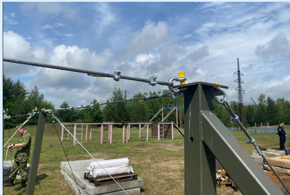
Узел крепления тросов к стойке
