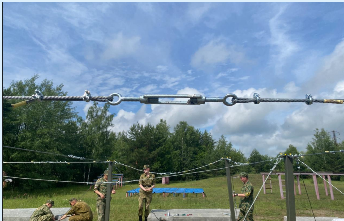
Узел крепления троса и талреп DIN 1480 кольцо-кольцо
