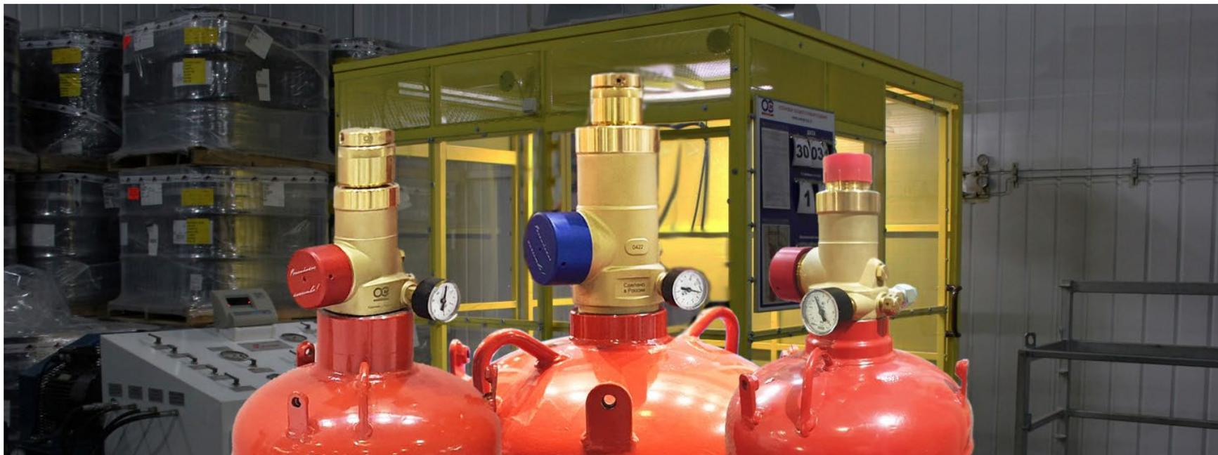
Модули газового пожаротушения МПА-КД комплектуются запорно-пусковыми устройствами (ЗПУ) товарной марки «БРАНДСИС 0418» и «БРАНДСИС 0421» с диаметрами условного прохода **Ду 50 мм** и **Ду 33 мм**
