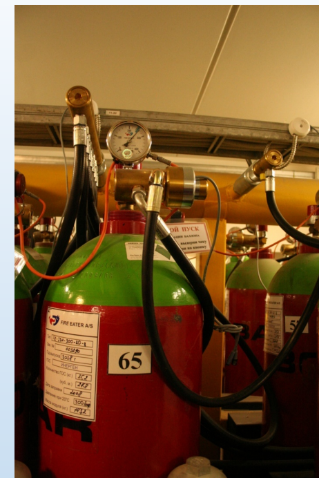
Запорно-пусковое устройство и электромагнитный активатор
