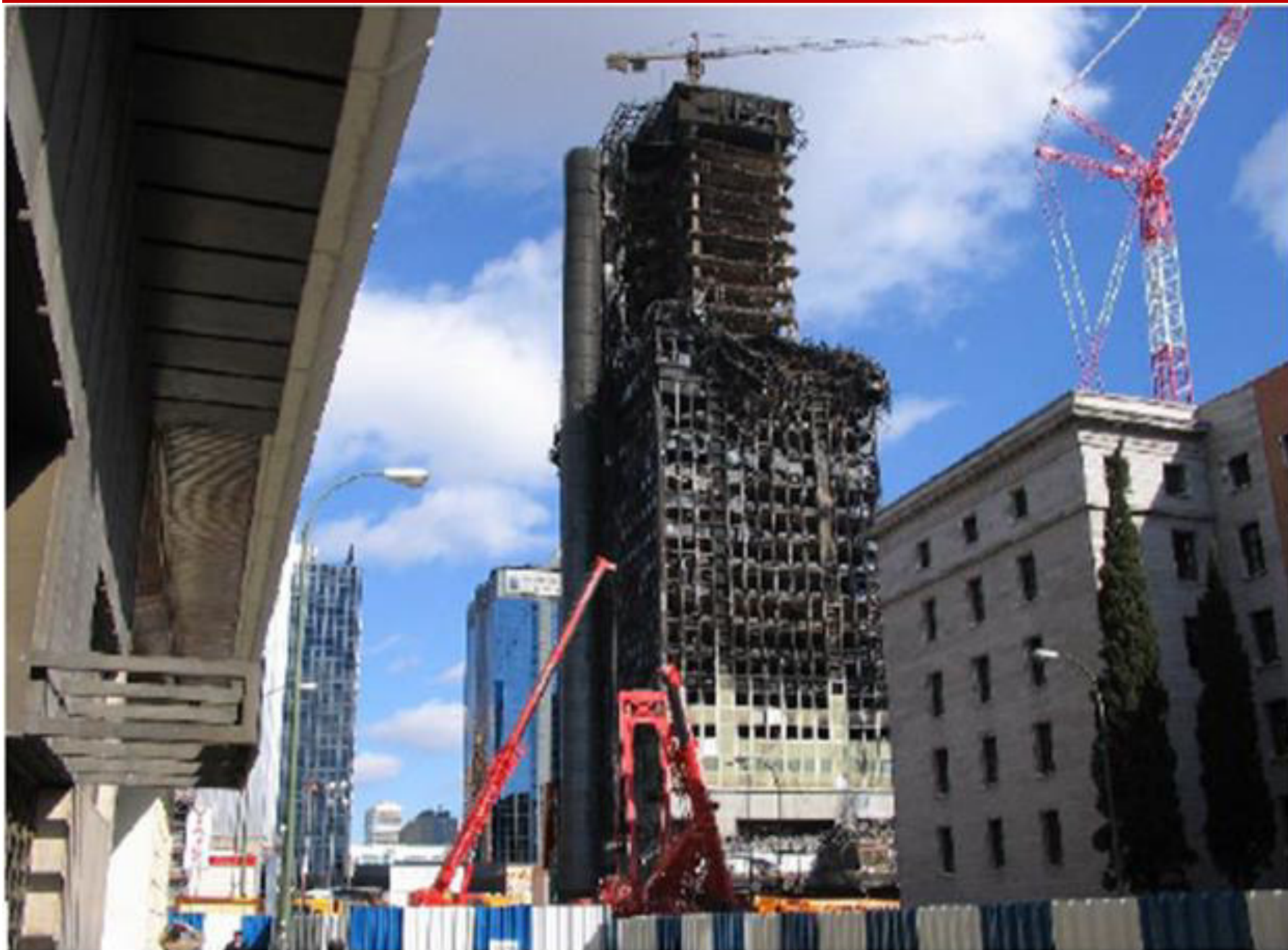
После пожара в здании «Видзор-билдинг» в Мадриде в 2005 году
