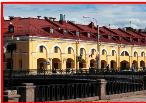
Гостиничный комплекс Holiday Inn и Meininger ООО «Никольские ряды», г. Санкт-Петербург
