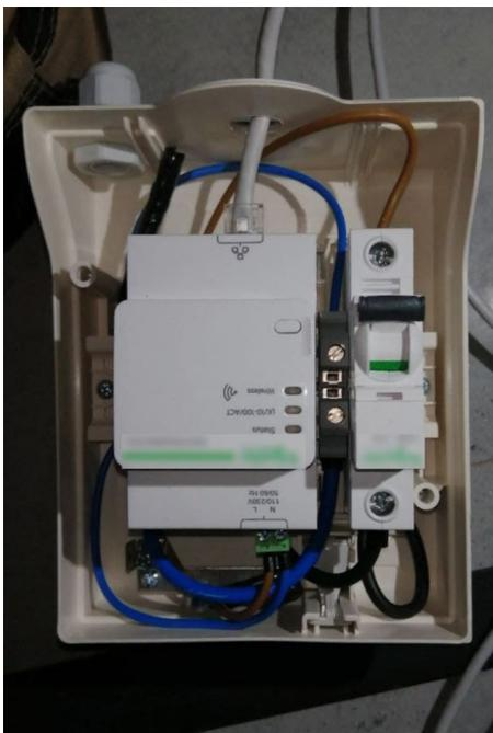
Установка датчика на 3Ф АВ
