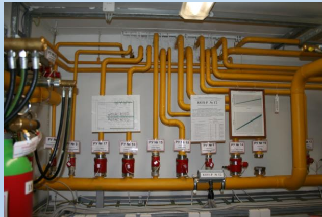
Распределительные устройства
