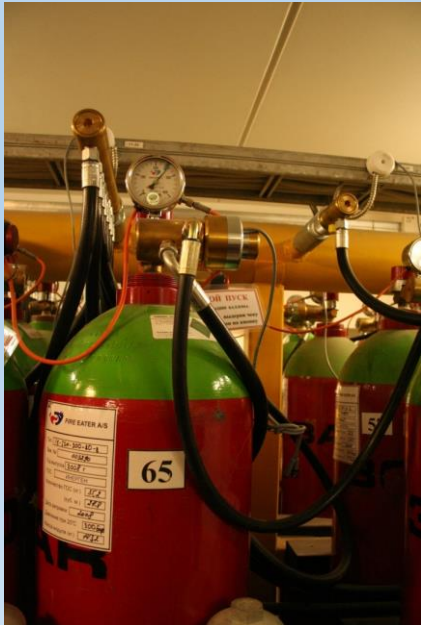
Станция газового пожаротушения РХЦ (корпус «Е»)
