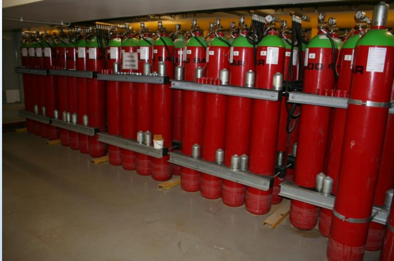
Станция газового пожаротушения РХЦ (корпус «Е»)
