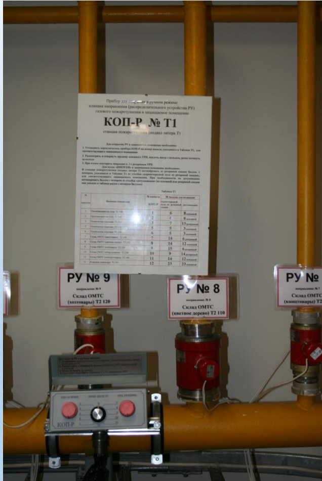
Коммутатор одиночного пуска
