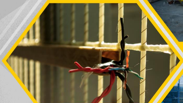
элементы жесткости - кабель-каналы
