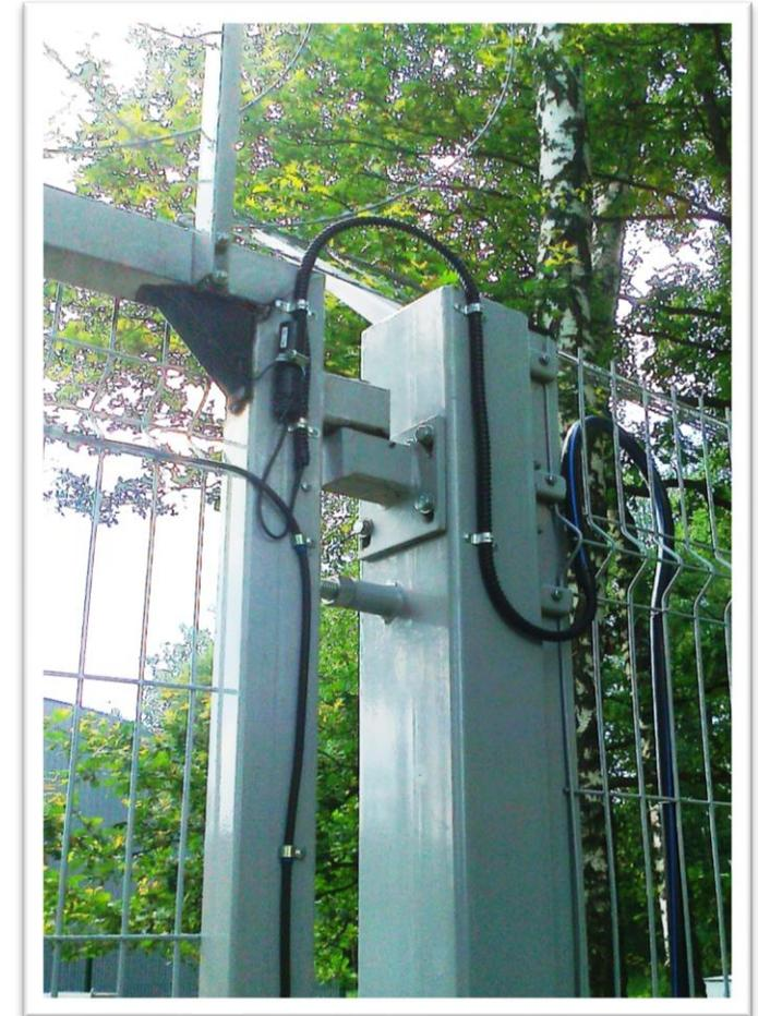
Вариант установки пьезоэлектрического сенсора СПВ-1Г с узлом крепления на воротах
