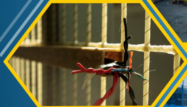
элементы жесткости - кабель-каналы
